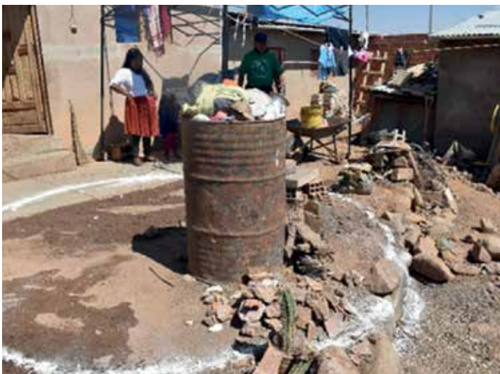
▲ Trazado del reservorio para la excavación
